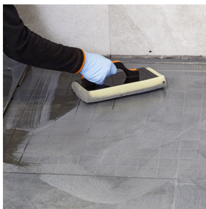
Efter ca 10–45 minuter ska den fogade ytan torkas av med en svampbräda och tvättas ren.
