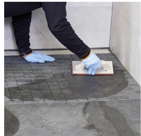
Mycket enkel fogning utan restsikt med PCI Durapox Premium.
