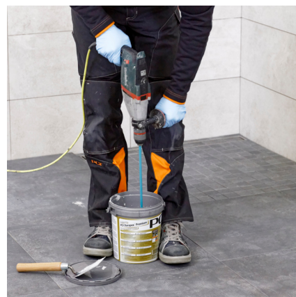
Blanda ordentligt. För att få en homogen blandning ska innehållet i behållaren hällas om och blandas igen.
