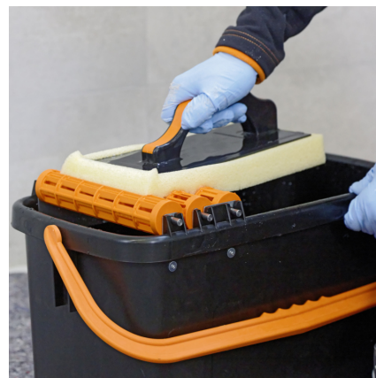
Det är viktigt att tvättvattnet byts med jämna mellanrum (ca 5 - 10 m 2 ).
