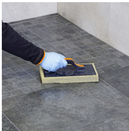
Använd därefter svampbrädan för att torka bort restsiktet och tvätta rent ytan.
